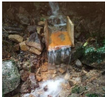
Figura 8 Canal de Madera direccionando el caudal existente
